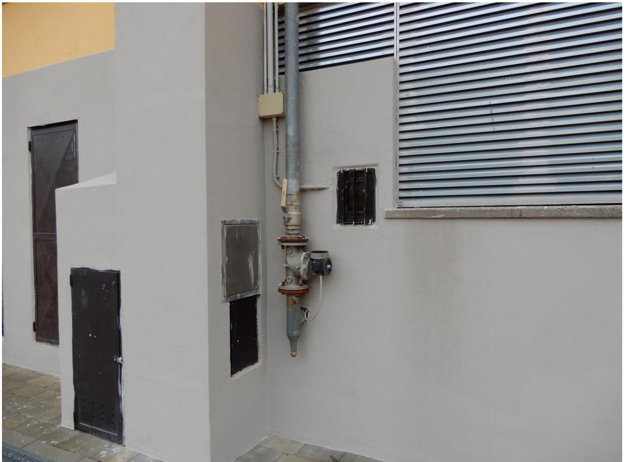
Foto n.19: Vista della valvola generale di intercettazione del gas metano della centrale termica dell'edificio
