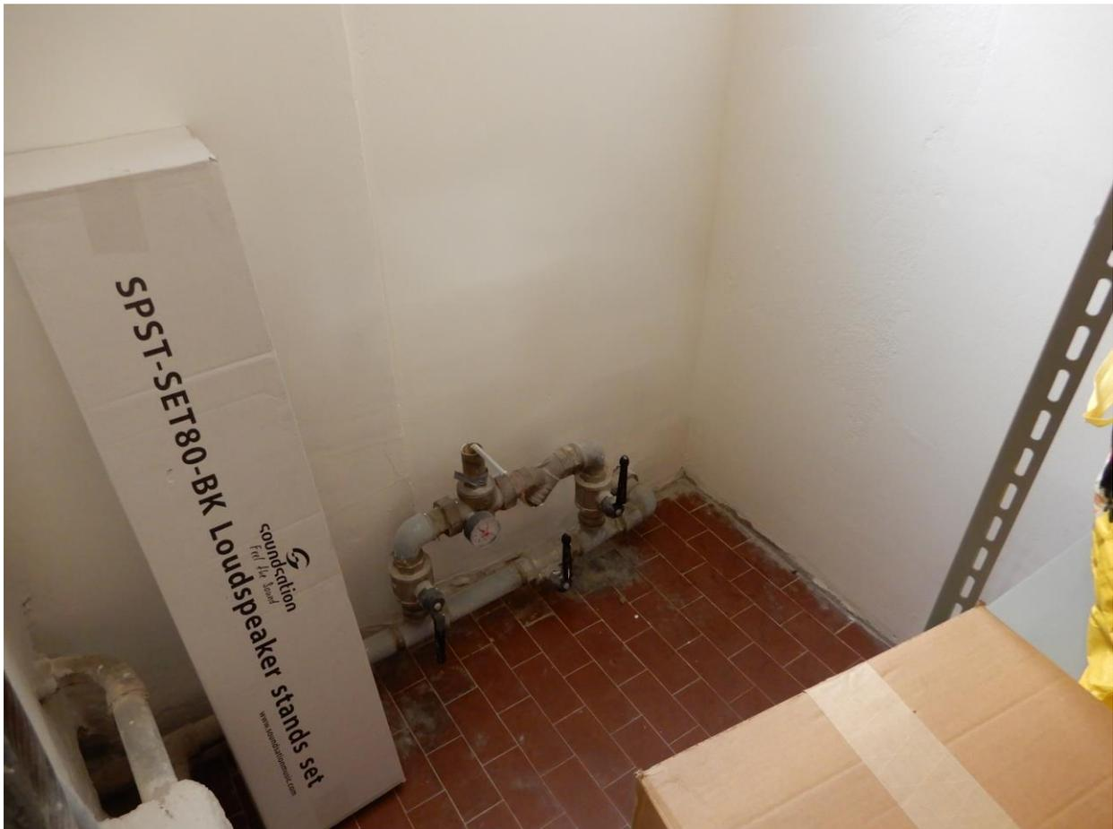
Foto n.21: Vista della valvola di intercettazione generale dell'acqua provvista di riduttore di pressione
