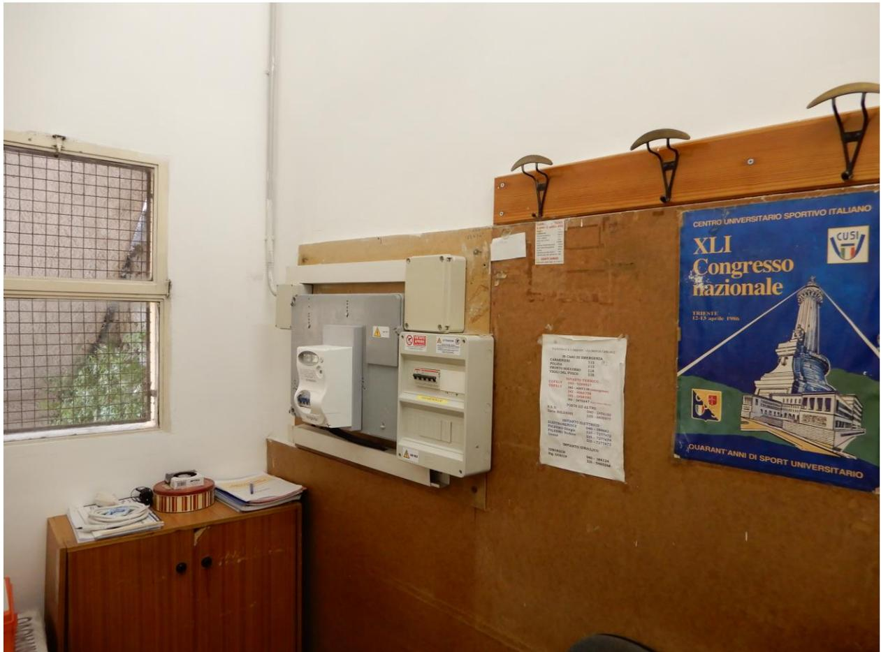
Foto n.20: Vista del quadro elettrico generale e del contatore elettrico principale dell'edificio, collocato nella portineria d'ingresso, lato via F. Severo, 42-44, provvisto di interruttore generale
